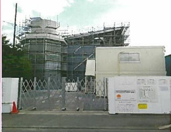
工事が始まった有馬図書館・門沢橋コミセン
