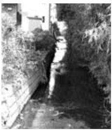
▲大雨による浸水が 懸念される釜坂川
