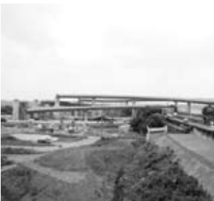
▲開通に向け工事進行中
