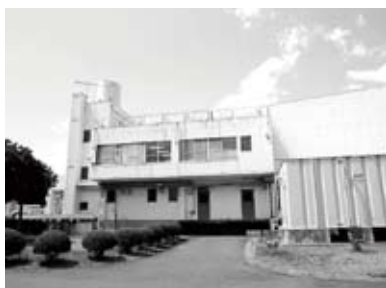
▲老朽化が目立つ学校給食センター
