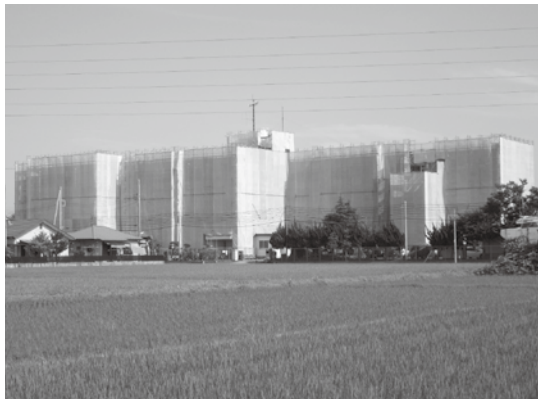
外壁塗装工事中の門沢橋小学校 ～公共施設のあり方は今後の大きな課題～
