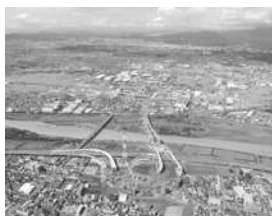
建設中の海老名南ジャンクション
