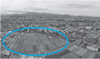
着工前の丸田地区
